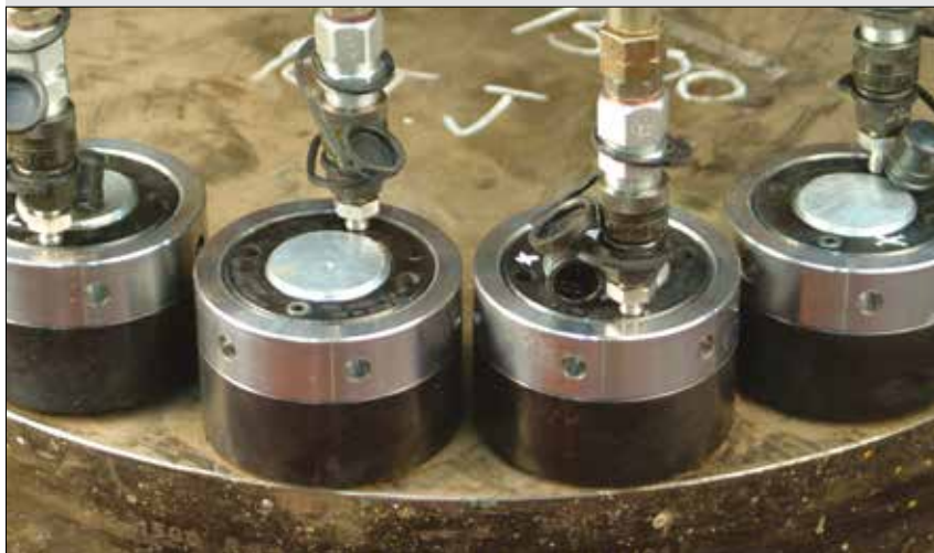
▲ Tensionamento con dadi idraulici.
