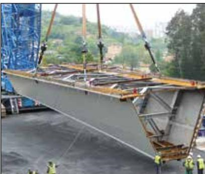
▼ Les techniciens d'amarrage (élingueurs) ont eu recours au système SyncHoist pour contrôler chaque point de levage avec précision, soit indépendamment les uns des autres, soit ensemble de manière synchronisée, afin de positionner le module de 1140 tonnes d'une centrale nucléaire.
