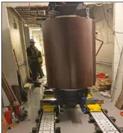
▼ Assemblage du système de ripage faible hauteur (LH400).
