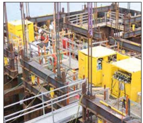
▼ Système de levage auto-verrouillable Enerpac Cube Jack SCJ50
