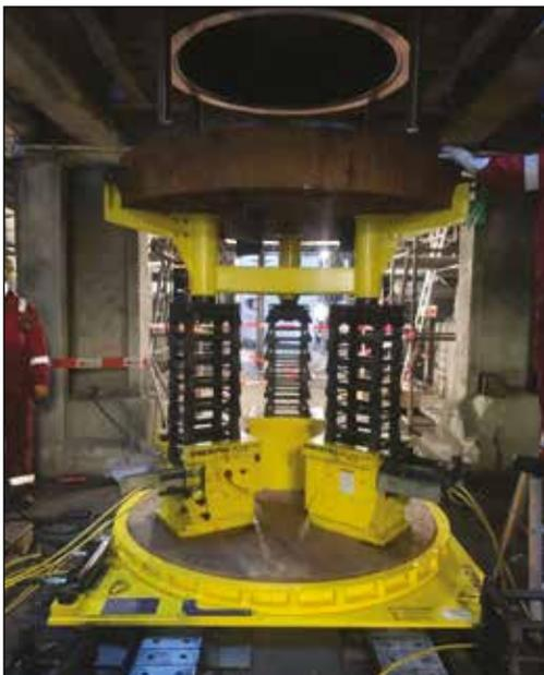
◀ Travaux d'entretien des circuits de régulation de la température sur la tuyauterie et les condensateurs d'une raffinerie à l'aide d'une combinaison de technologies de levage de charges lourdes Enerpac : systèmes auto-verrouillables Cube Jack série SCJ, plateau tournant hydraulique série ETT et systèmes de ripage faible hauteur série LH.
