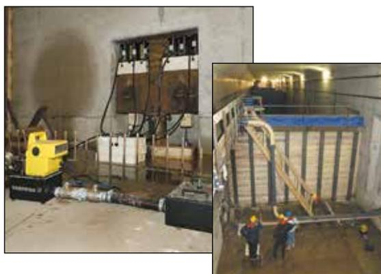
◀ Réalisés dans un alliage d'aluminium et ultra-légers, les remarquables vérins RAC506 Enerpac conviennent parfaitement à la mise en place des éléments de ce tunnel qui passe sous un cours d'eau (ligne de train à grande vitesse aux Pays-Bas).
