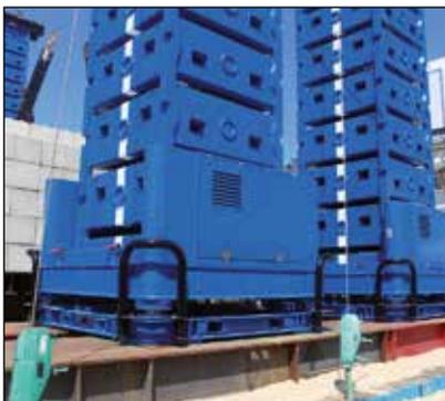
▼ Un système autoélevateur Enerpac soulève une travée de 1500 tonnes du pont de la rivière Fore.
