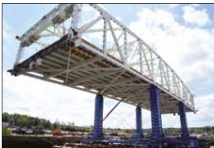
Elevación incremental de puentes
