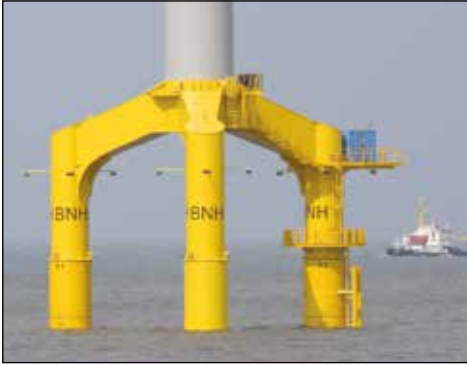
▲ Nivelación de turbinas eólicas marinas: El sistema de elevación sincronizada de Enerpac aportó la solución para nivelar los pilares de apoyo para las 80 turbinas eólicas.
