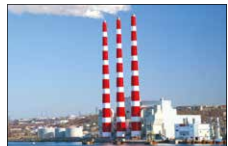
Generación de energía
