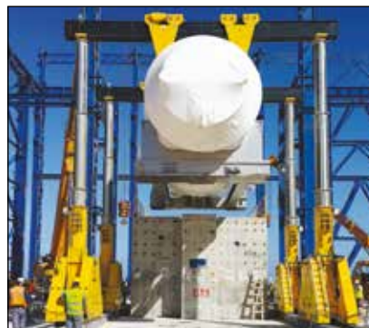
▼ Pórtico SBL1100 que descarga un generador grande para su instalación en una central eléctrica.
