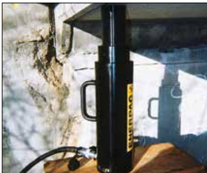
◀ Cilindro portátil RACL1506 con tuerca de seguridad utilizado para el soporte prolongado de la carga durante la inyección de resina epoxy para refuerzo de puentes.
