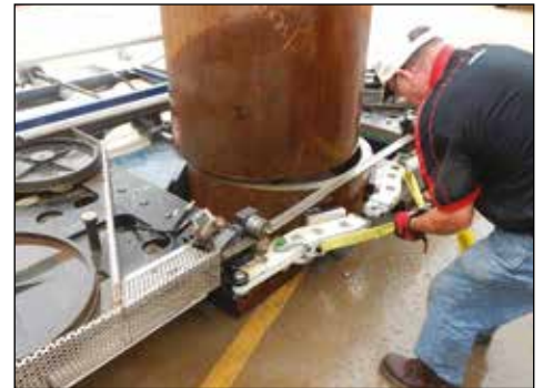
▲ Corte de tubos con sierra de cinta portátil BS.
