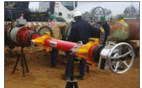
▲ Aplicación de hot tapping con CHT3000 para la instalación de oleoductos petroquímicos.
